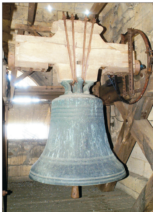
Liboire : Diamètre ext. : 119 cm, épaisseur: 8,2 cm, poids: 1004 kg, note: Mi 3.
