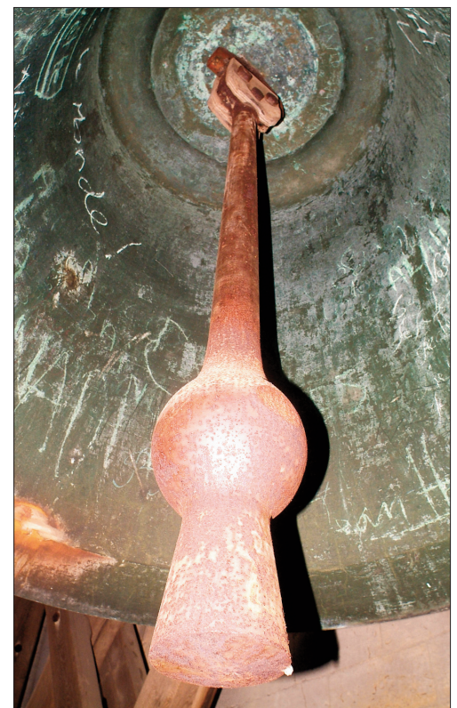
Battant du bourdon Julien . Fer, poids : 330 kg, diamètre de la boule de frappe : 28 cm.
