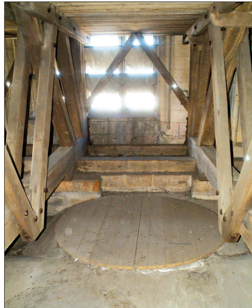
Au sol, voie de passage des cloches dans la tour.
