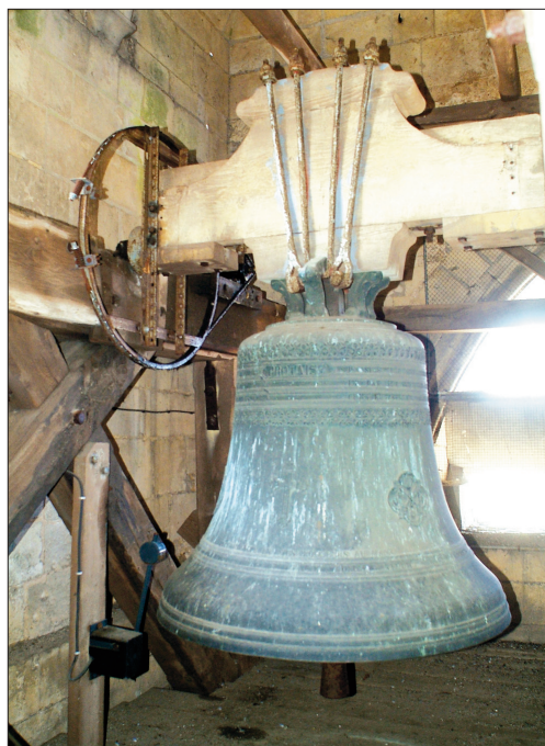
Protaise : Diamètre ext. : 128 cm, épaisseur: 8,8 cm, poids: 1255 kg, note: Ré dièse 3.
