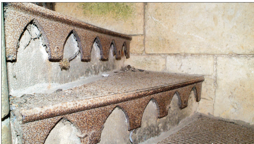
Escalier recouvert d'un dessus en fonte.
