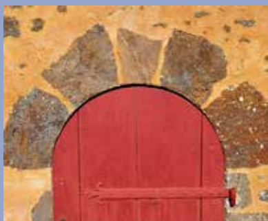
Figure 208 - Porte de cave d'une maison de tisserand avec arcade en grès roussard.
