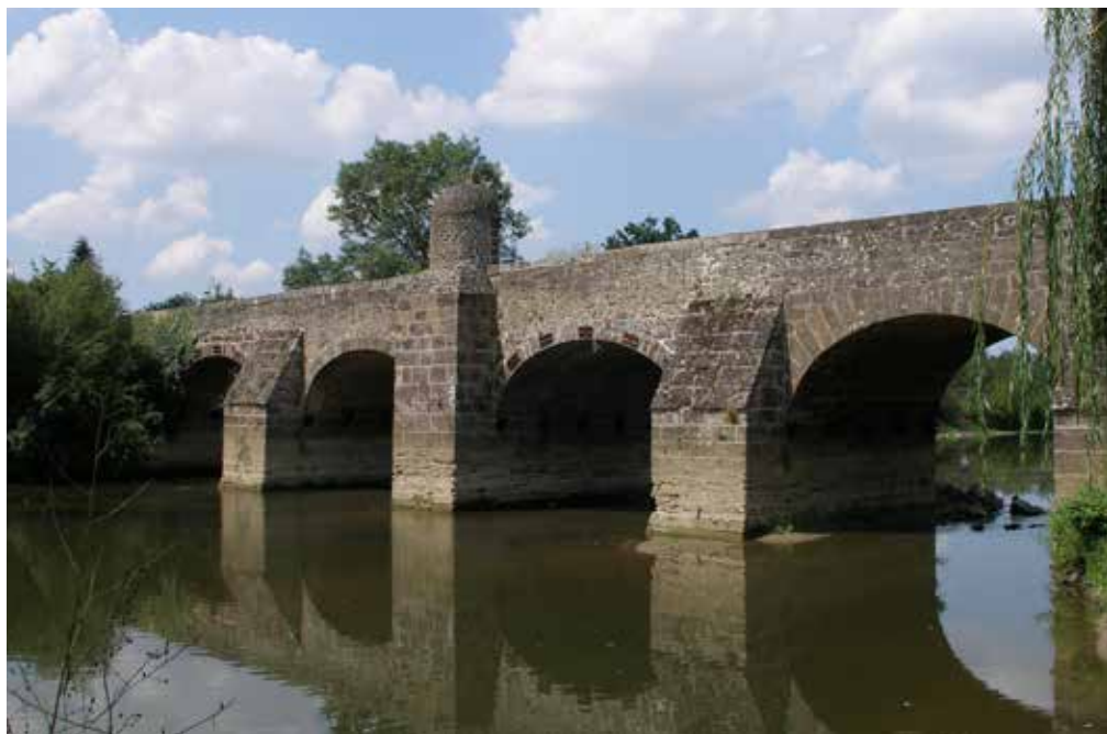
Figure 213 - Pont de Saint-Marceau réalisé en grès roussard, xvii siècle.
